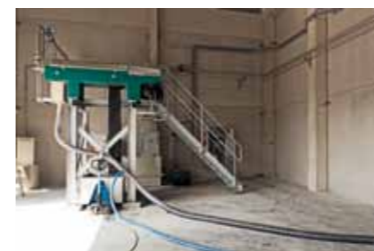
Na 24 uur wordt het afval uit de hydrolysetank naar de eigenlijke vergister overgepompt.
